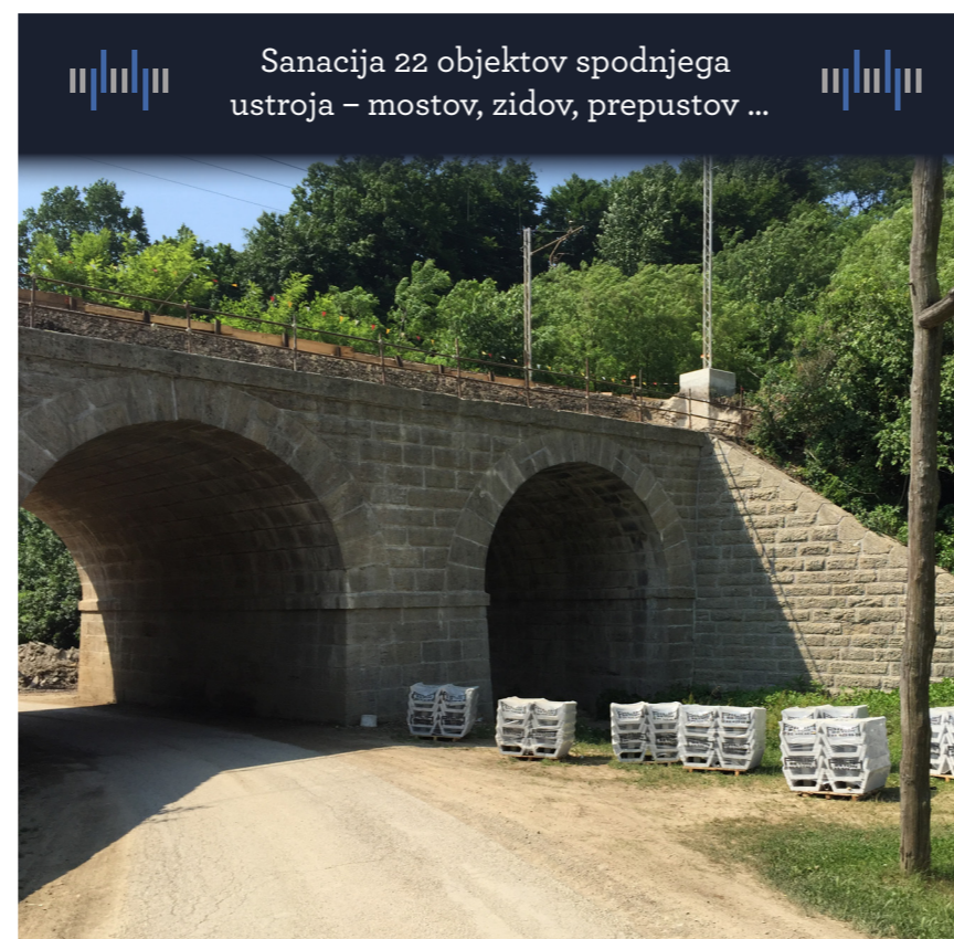
Sanacija mostu na odseku Dolga Gora–Poljčane
