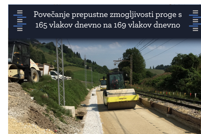
Vgradnja tampona debeline 70 centimetrov
