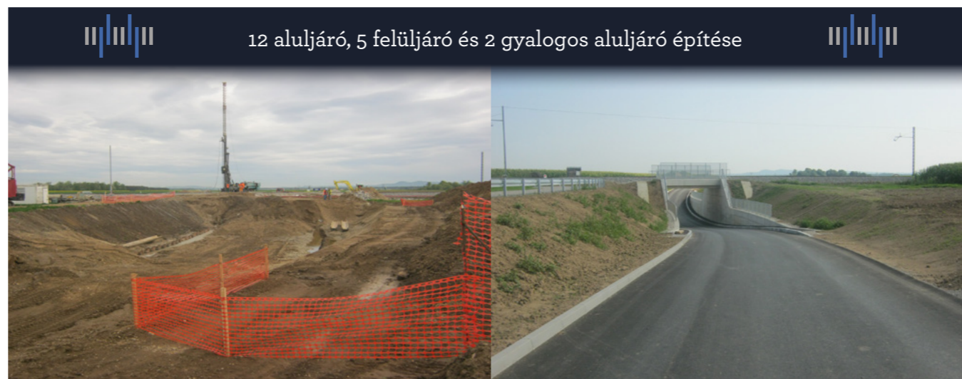
KORÁBBAN: Aluljáró építése Jablane településen
