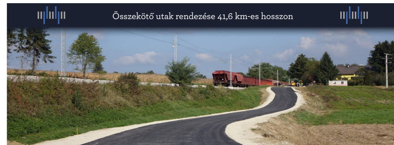
Összekötő út Ormož környékén – építés közben
