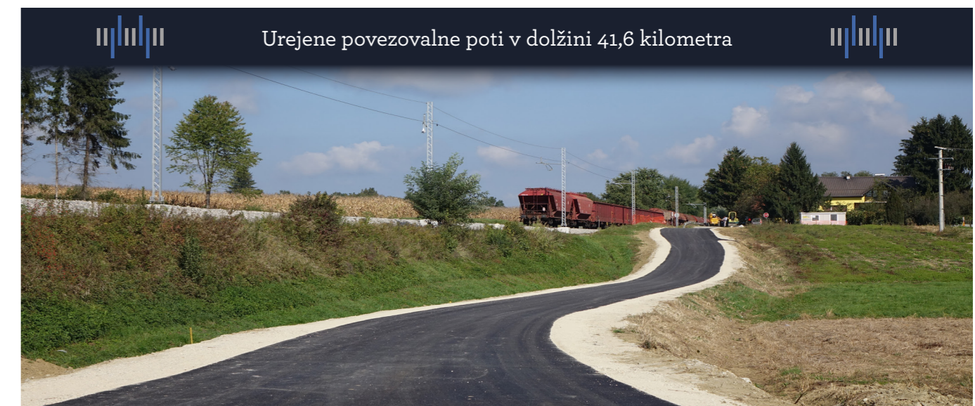
Med gradnjo povezovalne ceste v okolici Ormoža
