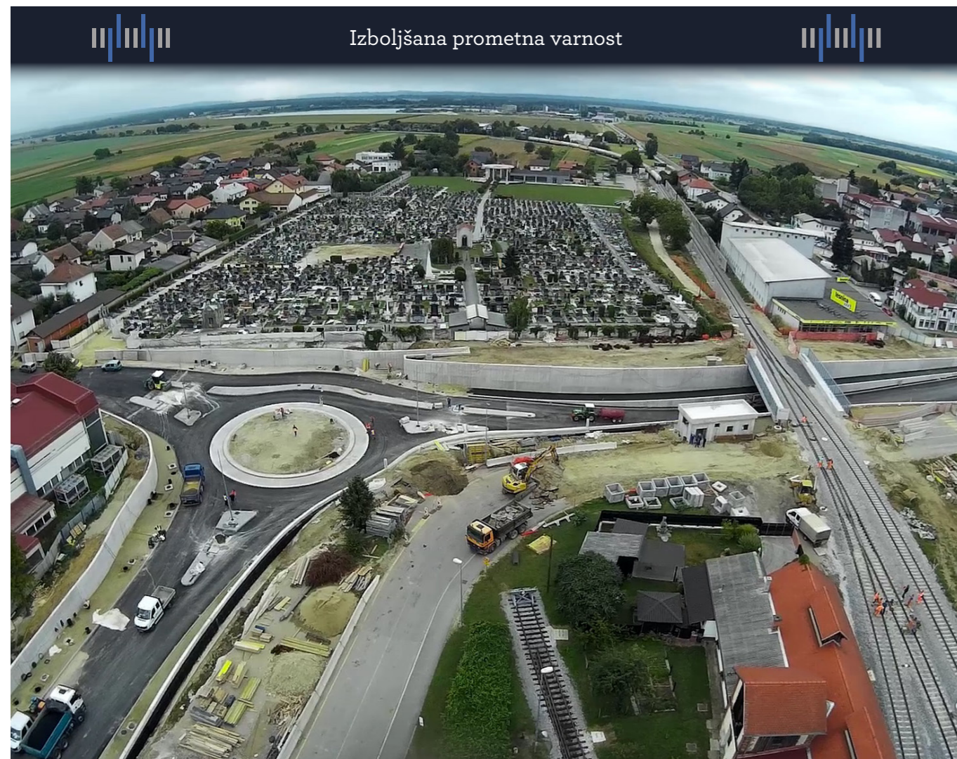
Med gradnjo podvoza v Murski Soboti, ki vključuje celostno ureditev dveh novih krožišč na Cankarjevi ulici in Panonski cesti
