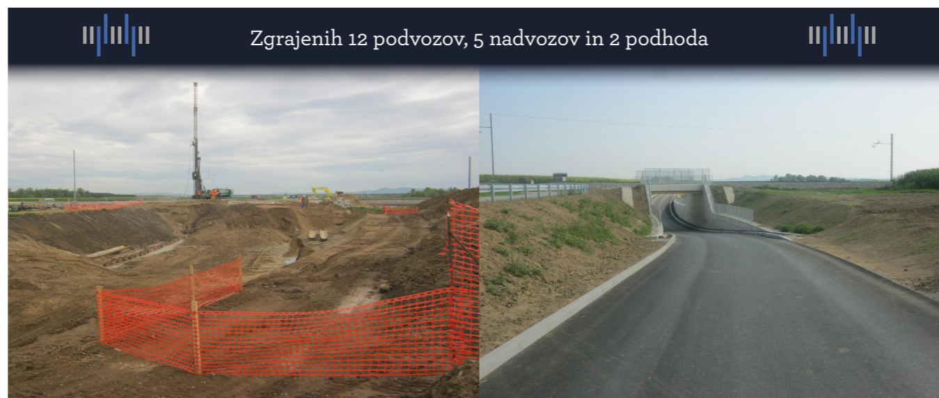
PREJ: Med gradnjo podvoza v Jablanah
