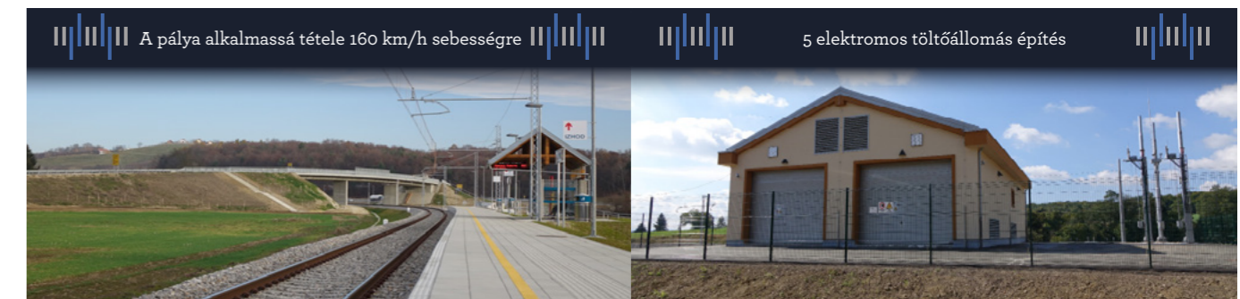
Új vasúti sínek a felújított pavlovczi vasútállomás előtt
