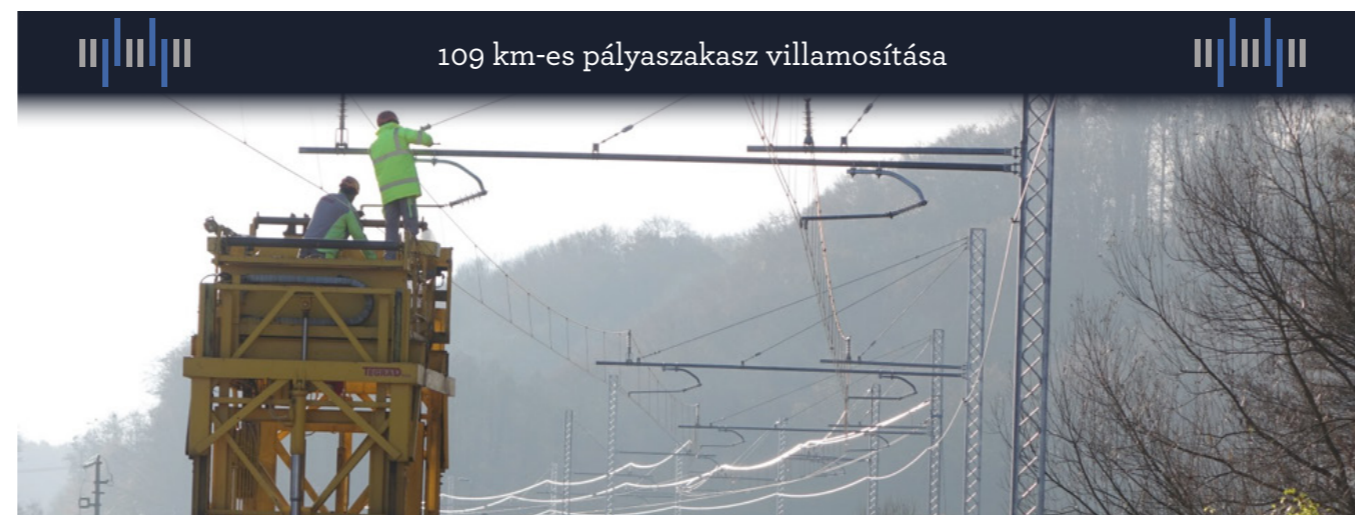
A villamos hálózat kiépítése
