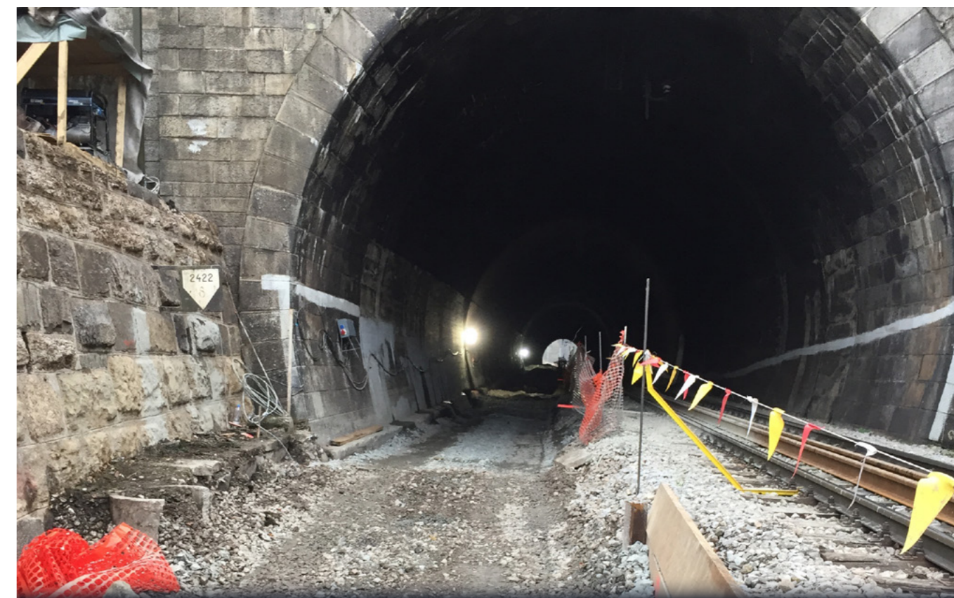
Prenova predora Črešnjevce
