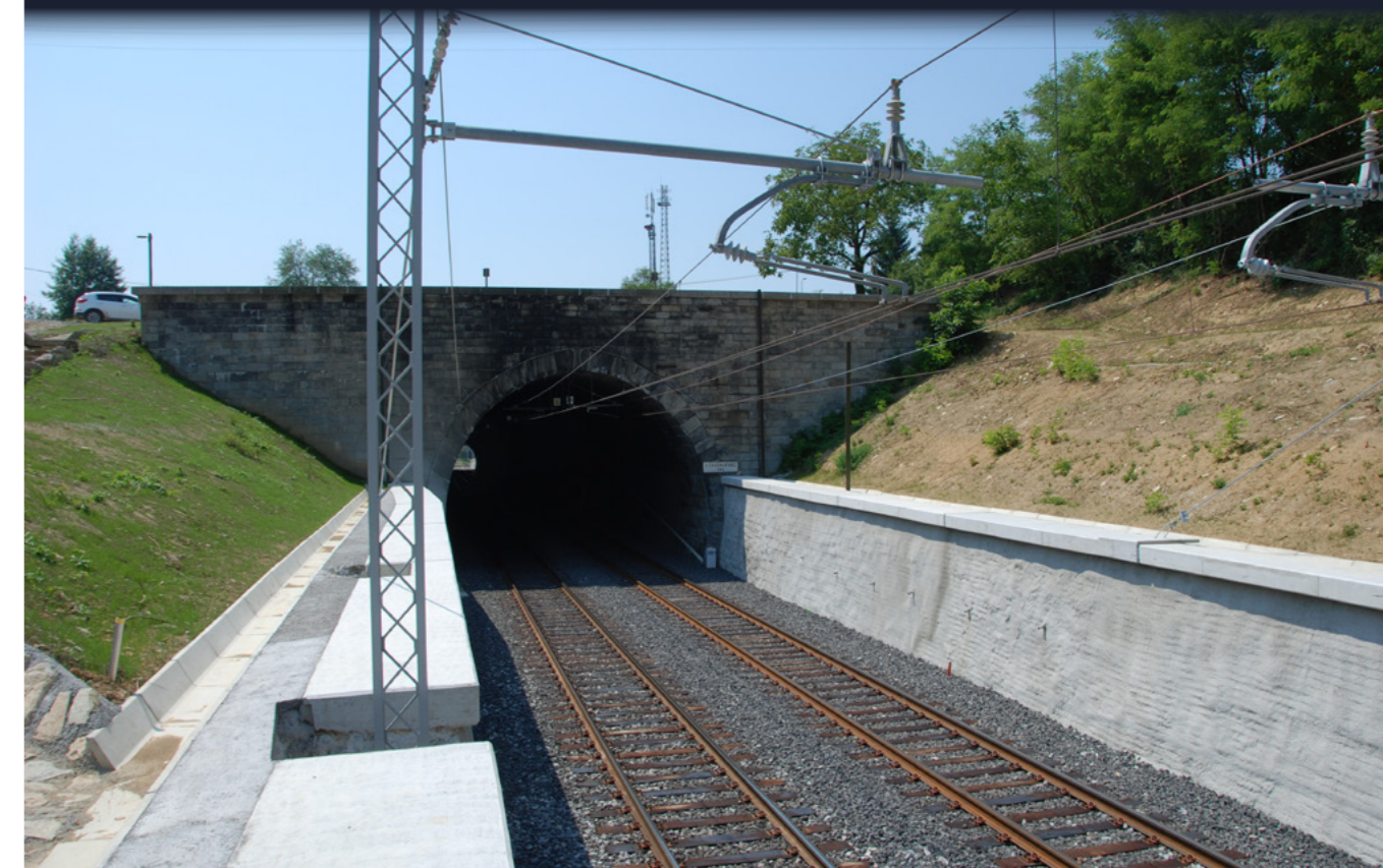
POTEM: Pogled na prenovljen predor Črešnjevce
