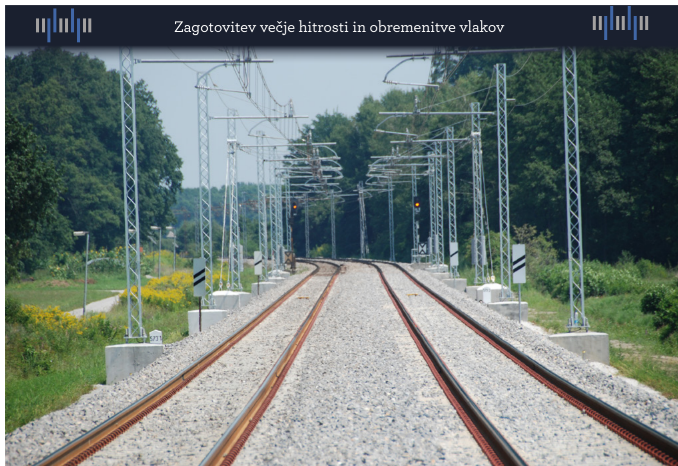
Nadgradnja tirov na odseku Slovenska Bistrica–Pragersko v skupni dolžini 4 kilometrov
